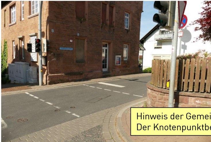
Fußgängerschutzanlage in der Aschaffenburger Straße
